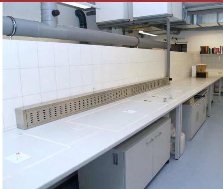
Fotos oben (von links nach rechts): Labortische mit integrierter Absaugfläche, Labortische mit Rückwandabsaugung
