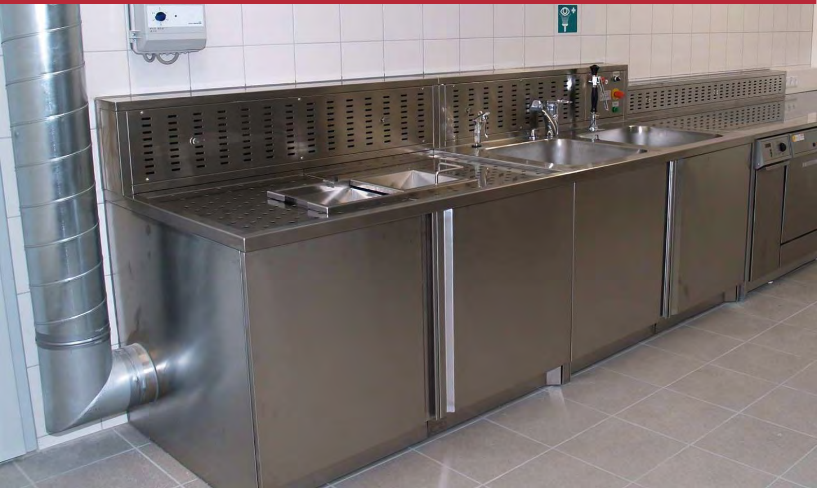
Foto oben: Formalinentsorgungsstation mit Formalinbecken zum Entsorgen und Trennen von Altformalin mit Absaugung nach unten und nach hinten zur optimalen Schadstoffabsaugung
