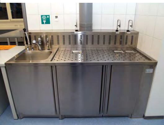
Fotos oben (von links nach rechts): Formalindispensanlage, Ausgabebehne fr Formalin, Xylol und Alkohol, Kontrollschalter mit "NOT-AUS" Taster (rechtes Foto oben rechts im Bild)
