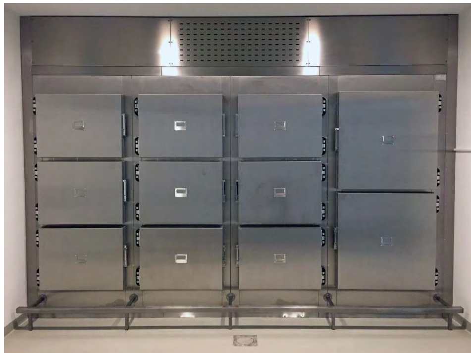
Fotos (von links nach rechts): Raumplan Leichenkühlung, Leichenkühlzelle aus Edelstahl mit 11 Luken für 11 Körper, 2 davon Adipositas
