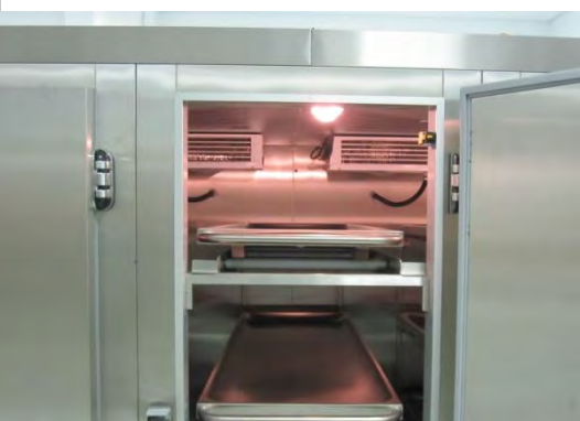
Foto oben: Leichenkühlzellen mit großen Türen zur Lagerung von Körpern auf Leichenmulden
