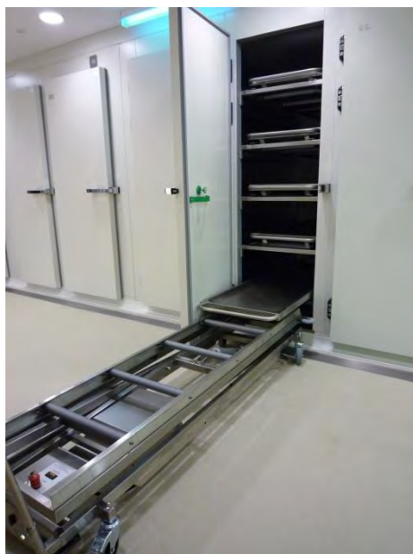
Fotos oben: Leichenkühlzellen mit großen Türen mit passenden Leichenmulden und Hub- und Transportwagen
