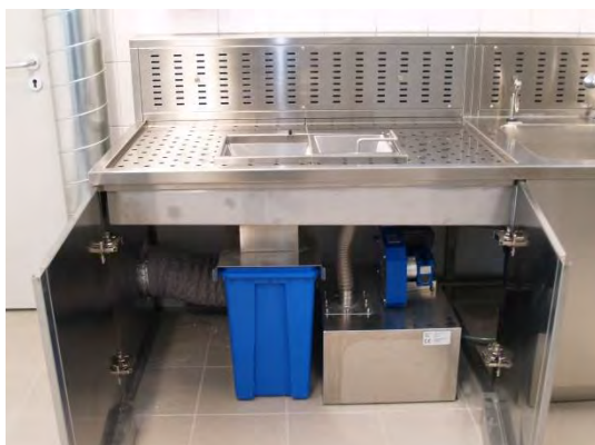
Fotos oben (von links nach rechts): Frontansicht der Formalinentsorgungsstation (geschlossen), Frontansicht der Formalinentsorgungsstation (geöffnet, mit 10 Liter Kanister für Altformalin), Edelstahlbecken mit Kontrollschaltern
