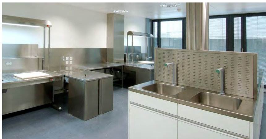
Fotos oben (von links nach rechts): Zuschneidetisch UCS-E-1500 mit Absaugung nach unten, Rückwandabsaugung auf duale Edelstahlbecken montiert
