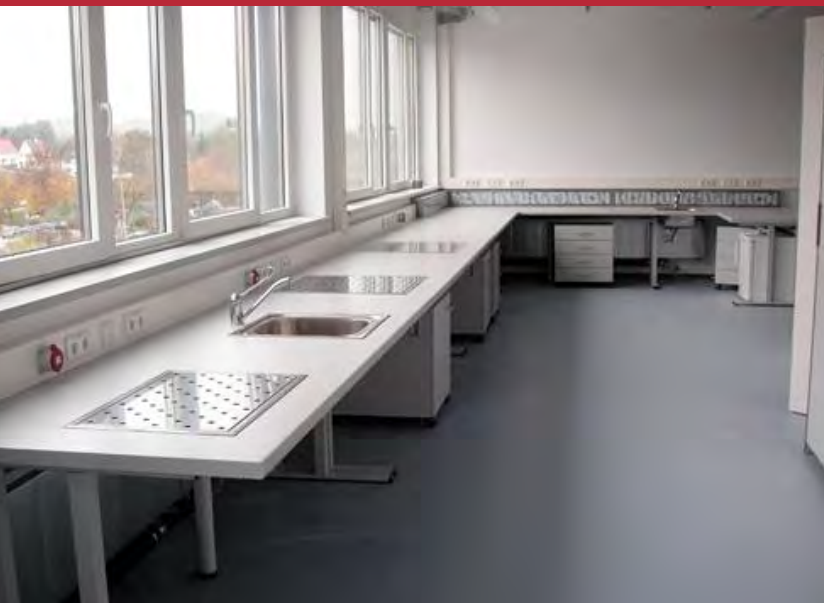
Fotos oben (von links nach rechts): Labortische mit integrierter Absaugfläche, Labortische mit Rückwandabsaugung
