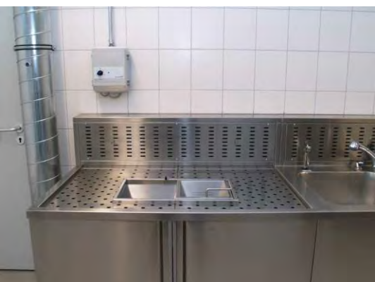
Fotos oben (von links nach rechts): Frontansicht der Formalinentsorgungsstation (geschlossen), Frontansicht der Formalinentsorgungsstation (geöffnet, mit 10 Liter Kanister für Altformalin), Edelstahlbecken mit Kontrollschaltern
