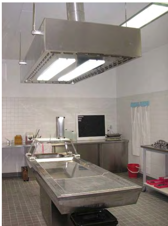
Fotos (von links nach rechts): Raumplan Sektionsraum, höhenverstellbarer STV 10/850 Seziertisch mit Absaugung nach unten und einer ZU 10/900 Zulufthaube über dem Seziertisch.
