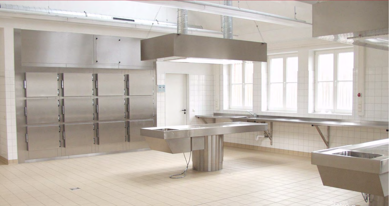
Foto oben: KZM 40/01200 Leichenkühlzelle mit 12 Luken für 12 Körper, zwei ST 10/100 Seziertische mit jeweils einer ZU 10/900 Zulufthaube über dem Seziertisch
