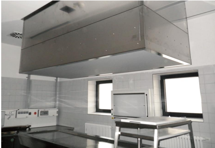
Laminarflow-Zulufthaube mit zusätzlicher Verblendung
